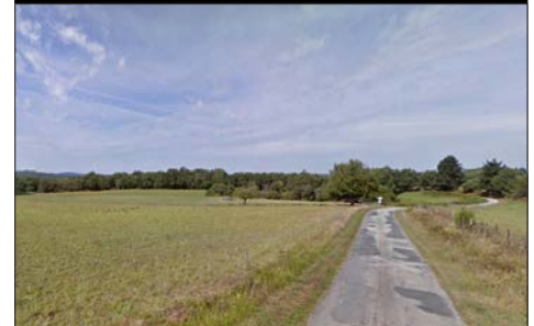
29. PDV ROUTE DE CAUX
