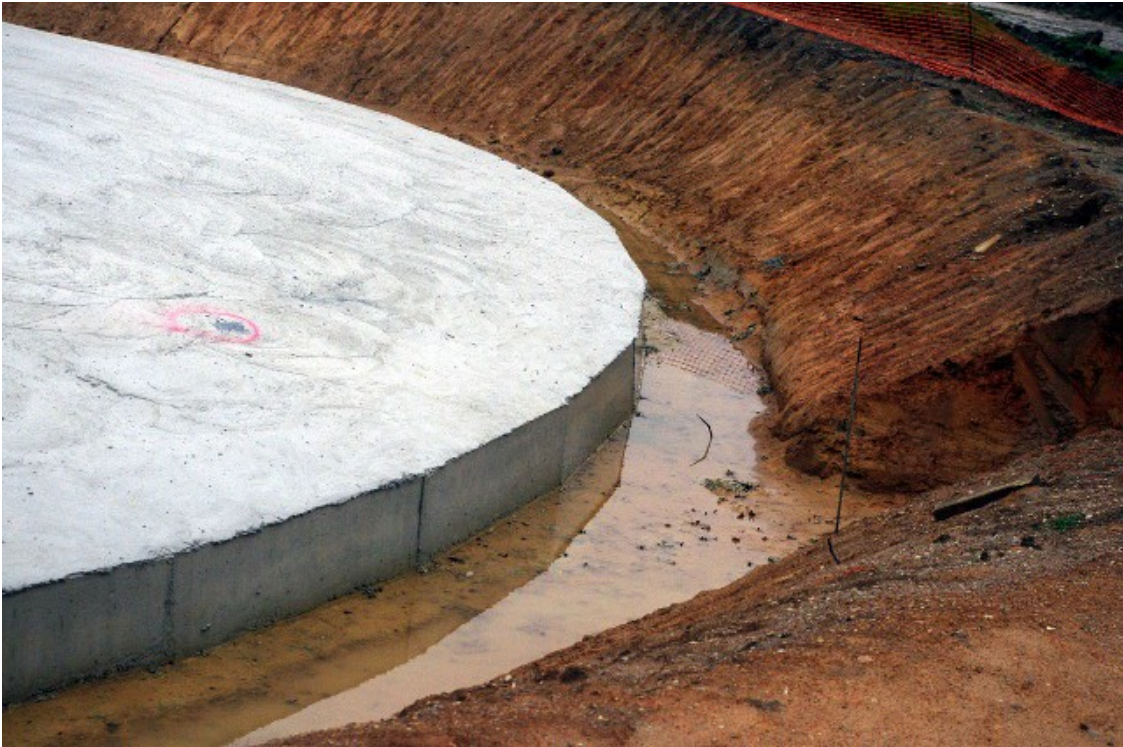
Illustration 3: Détail du socle avec de l'eau stagnante
