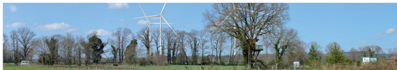
Vue panoramique vers le projet depuis la D228, au nord de Puy de Bos et à proximité du château d'eau (Vue 30 du carnet de photomontages) (Source : ENCIS Environnement)
