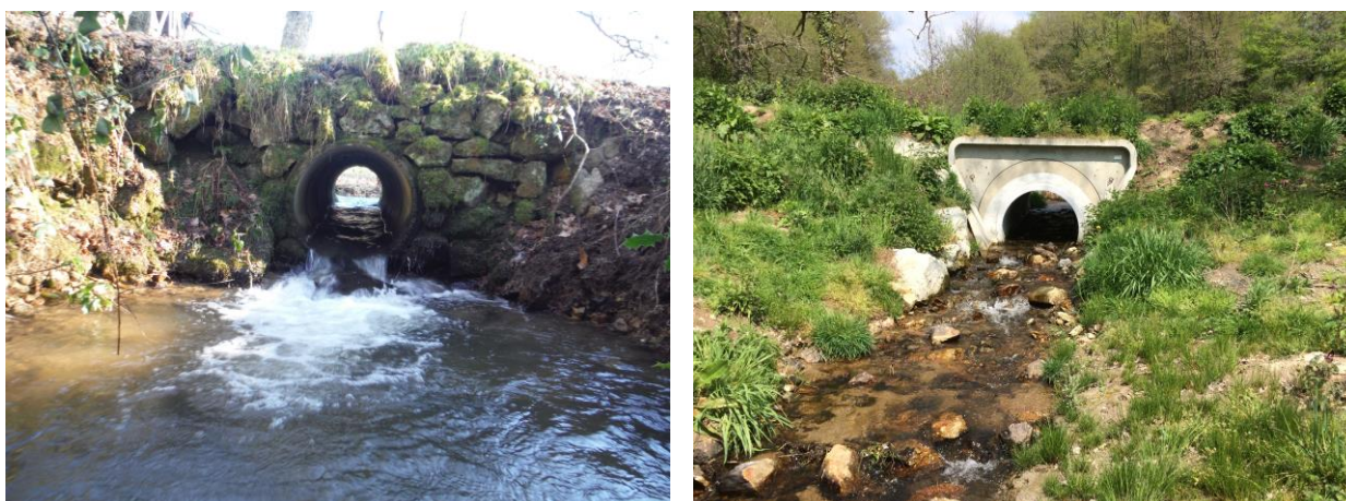
Remplacement d'une buse sous voirie sur le ruisseau de Fourchat
