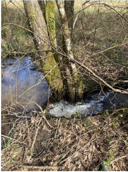
Pousse d'arbres dans le cours d'eau
